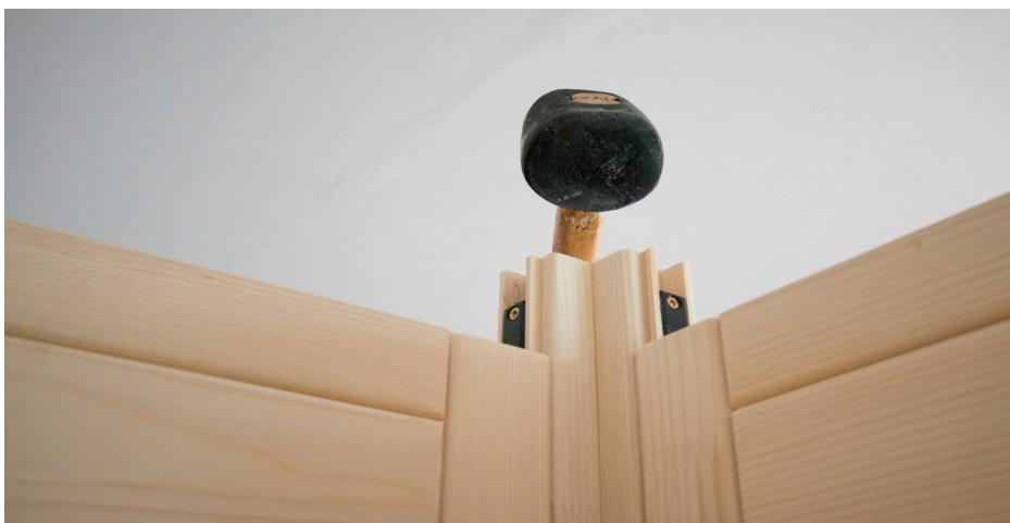
**Montagem dos elementos de parede**
