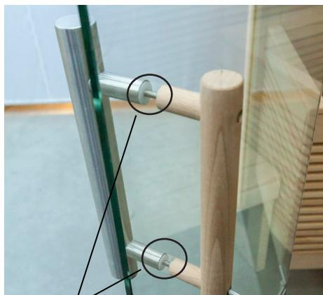
Přiložení plastových příložek u rukojetí z nerezové oceli
