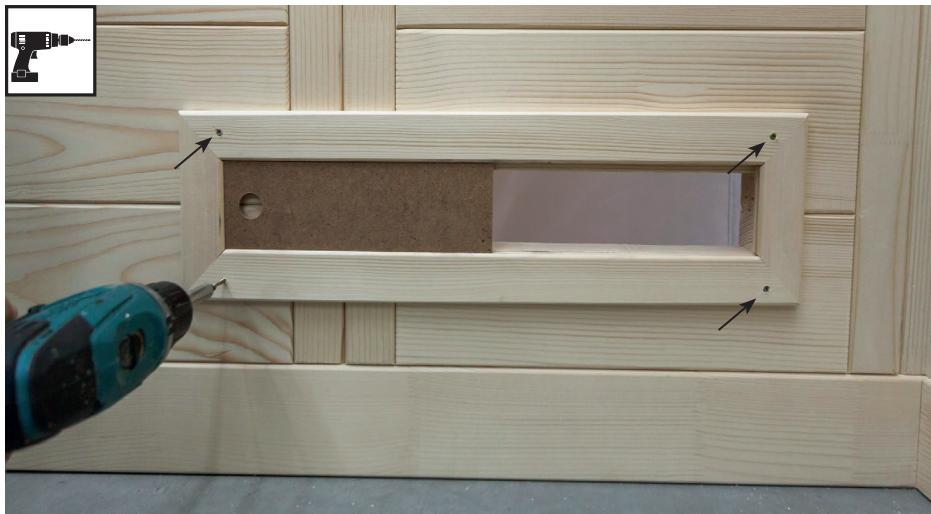
Bohrer 3 mm, 4 Stk. Schrauben 3,5 x 40 mm
