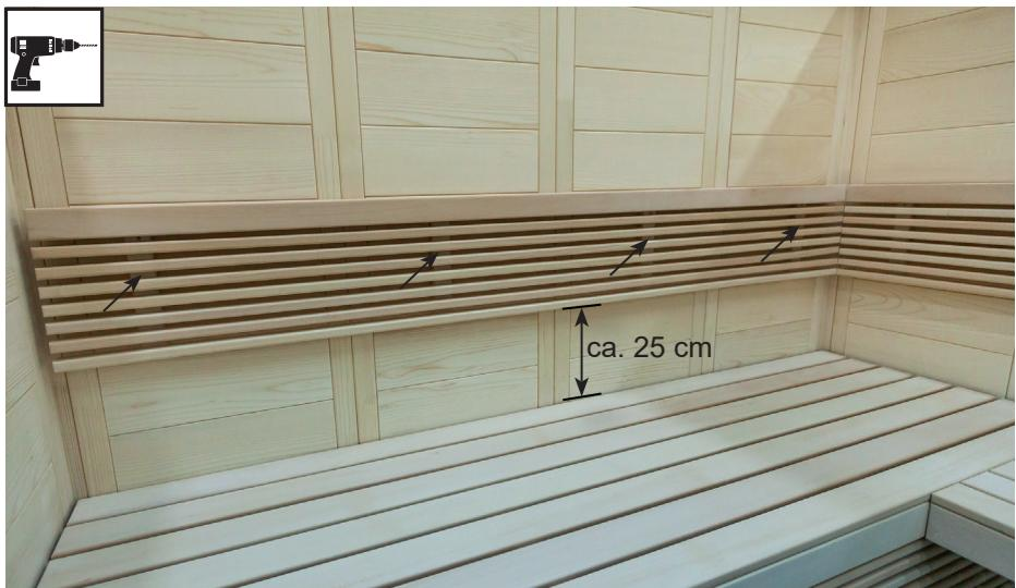
Bohrer 3 mm, 4 Stk. Schrauben 3 x 40 mm
