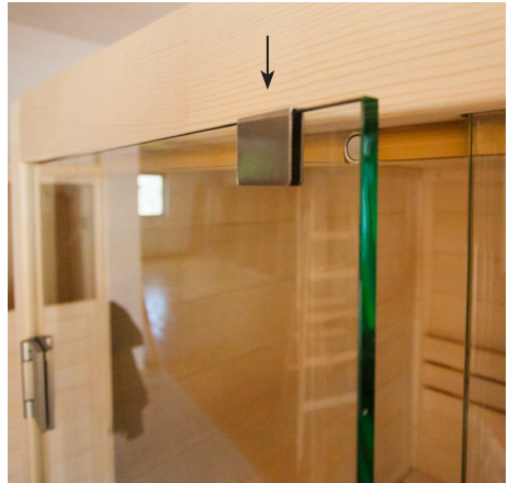
Kunststoff Beilagscheibe bei Niro-Griff beilegen
