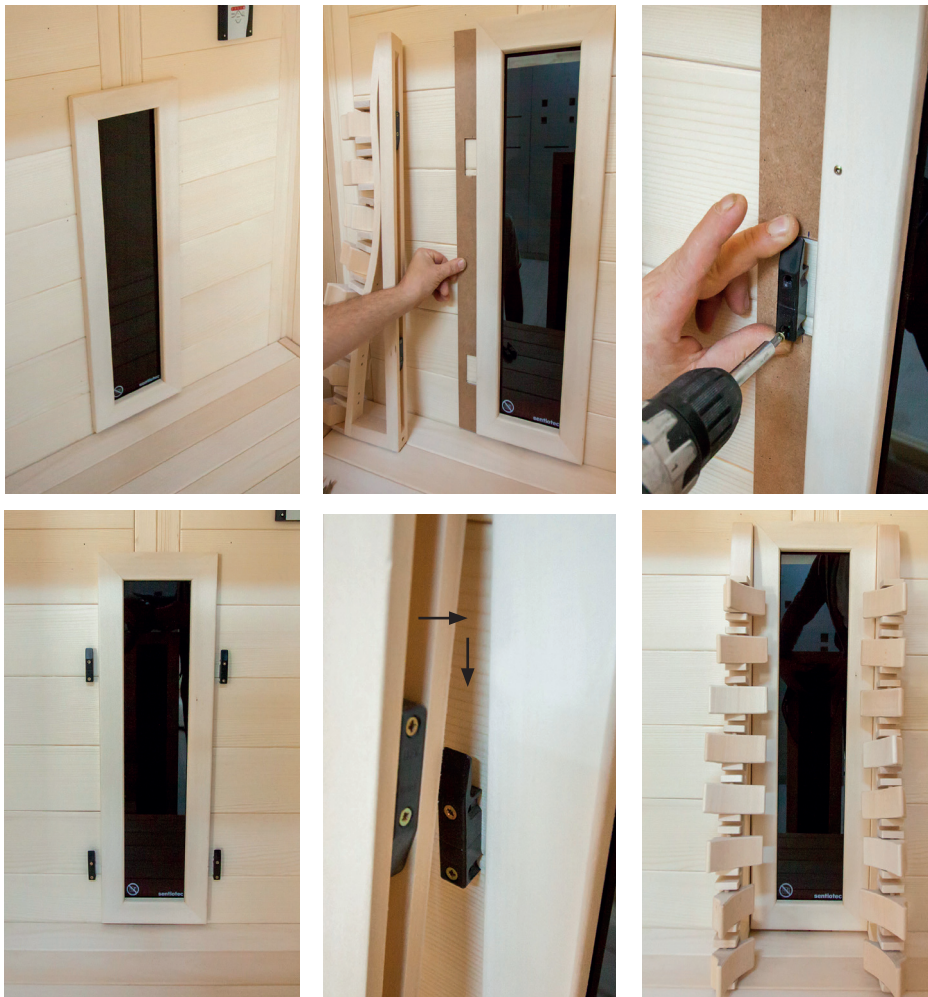
Fig. 29: Montaggio degli schienali
