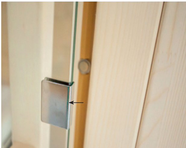
Afb. 35: Montage overschuifplaat
