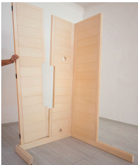
Fig. 6: Inserimento dell'elemento parete con intaglio
