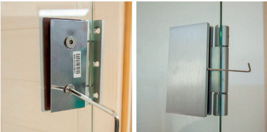
Fig. 32 : Montage des ferrures de portes 2
