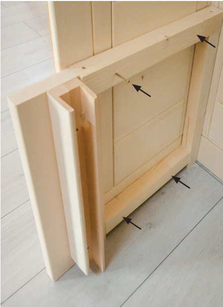
Abb. 18: Bankauflagen montieren
