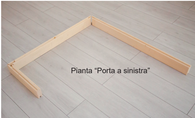
Fig. 1: Posizionamento di tre elementi del telaio di base
