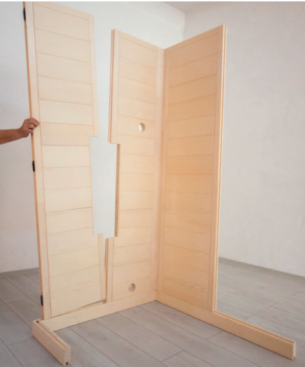
Fig. 6 : Insérer l'élément mural avec la découpe
