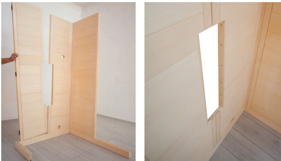
Fig. 6: Instalar o elemento de parede com abertura
