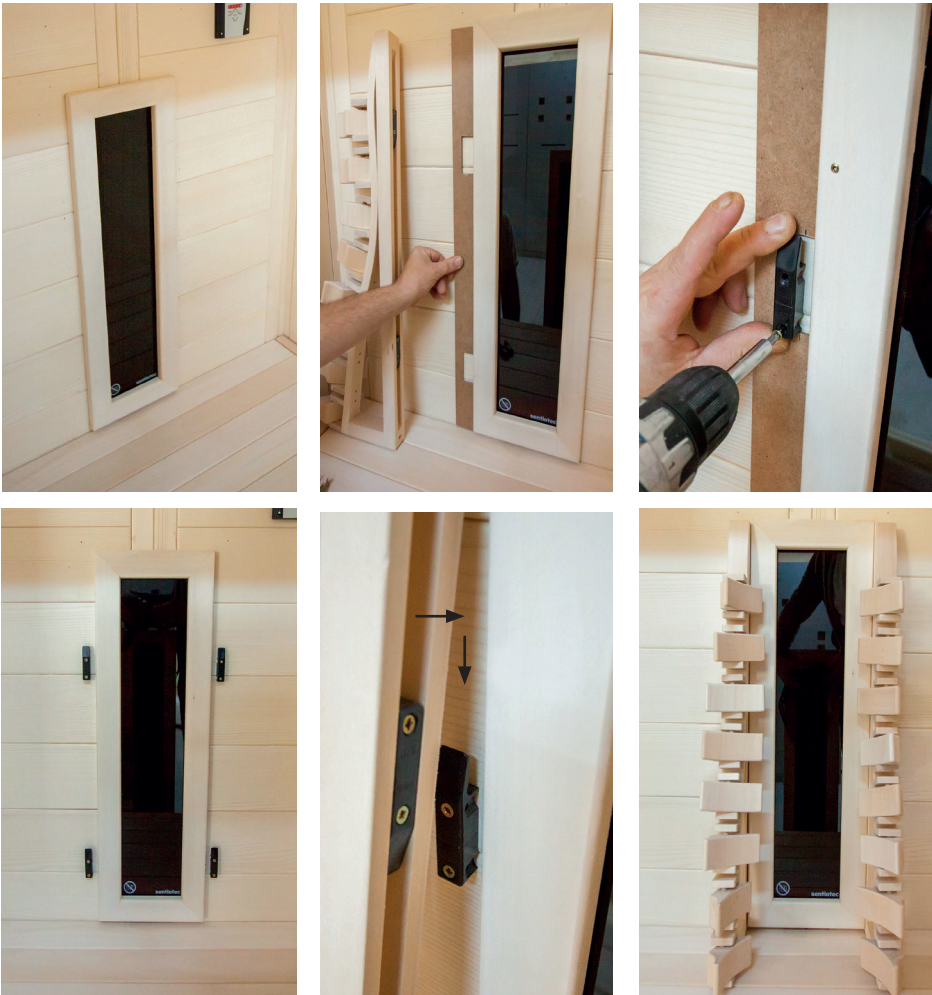
Abb. 29: Montage Rückenlehnen
