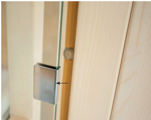
Fig. 35: Montagem da chapa de transferência
