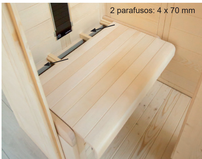
Fig. 27: Fixação do banco
