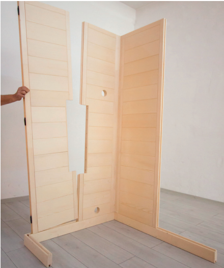
Abb. 6: Wandelement mit Ausschnitt einsetzen
