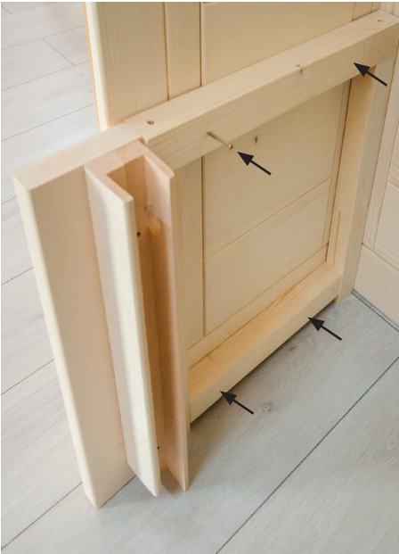
Fig. 18: Montare i supporti della panca
