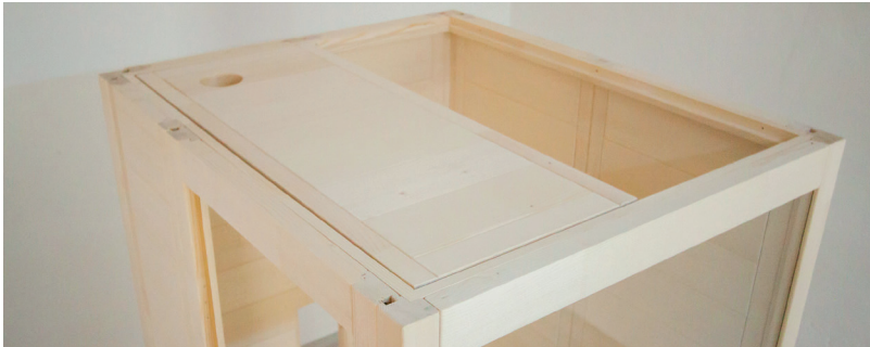
Abb. 14: Einlegen Dachelemente vorne
