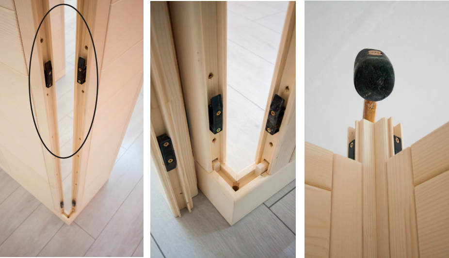
Abb. 4: Wandelemente mit Ecksteher verbinden
