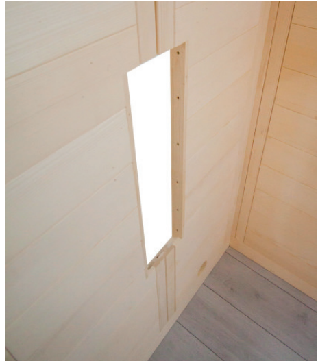
Fig. 6 : Insérer l'élément mural avec la découpe
