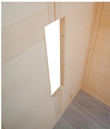
Fig. 6: Inserimento dell'elemento parete con intaglio
