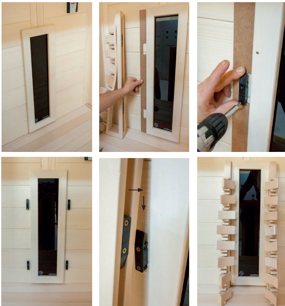
Fig. 29 : Montage des dossiers
